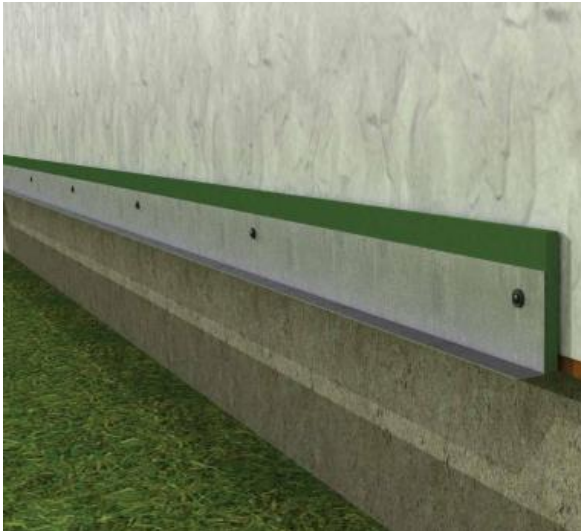
Bild ovan: montering av startprofilen på 5 mm distansremsa
